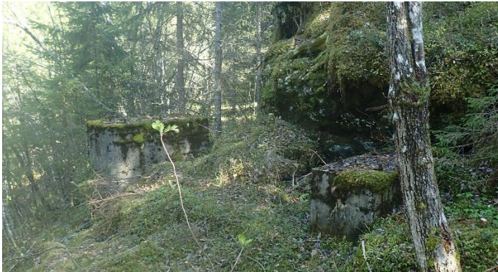
Figur 21. Betongklosser bygget for fundamentering av kablene som var spent over Estenstaddalen
