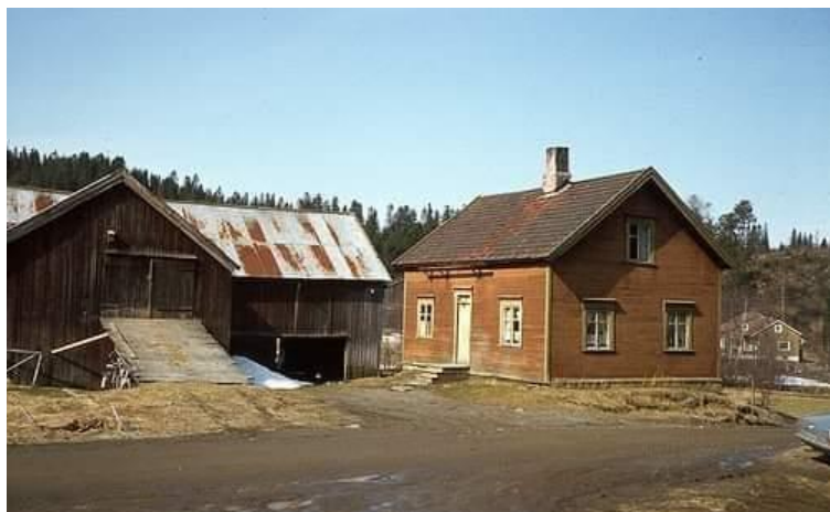
Figur 14. Foto av Husene på Bekken, før riving i 1970.
