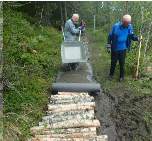
Utlegging av kavling, duk og grus sør for Kårstua
