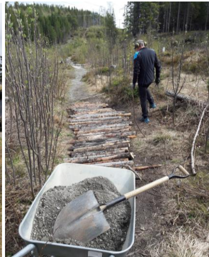
Kavling og grusing av sti nedenfor hytta
