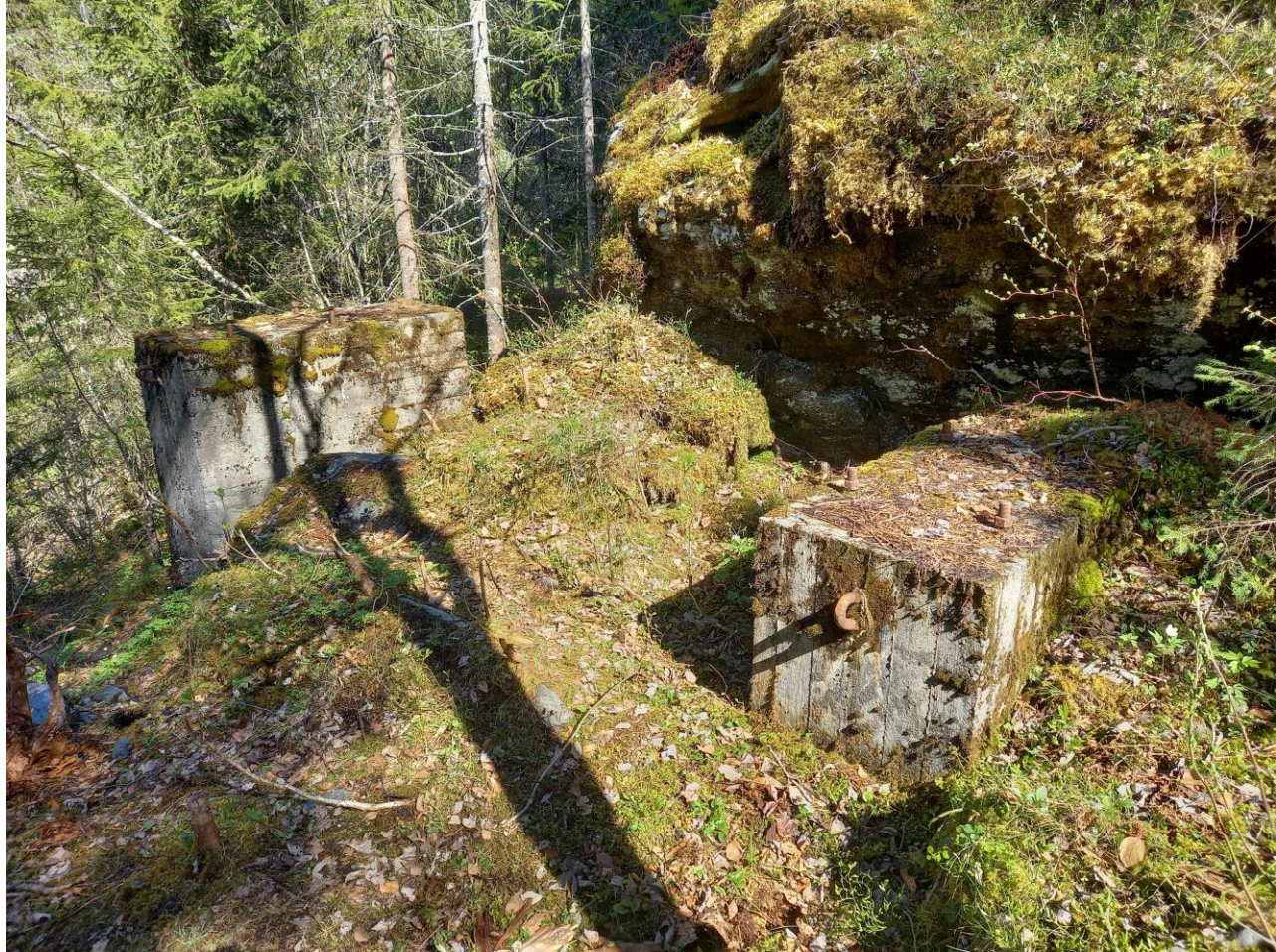
Fundamenter for kraftlinjespenn ved Burmaklippen 2028
